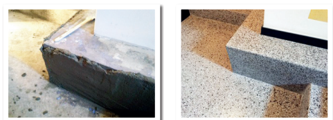
Lagning/nyläggning av terrazzogolv
