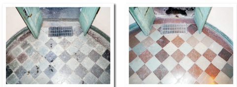
Slipning av naturstensgolv
